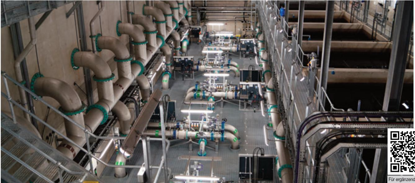
Bild 1 | Von Zu- bis Ablauf: Eine modulare SPS der Q-Serie von Mitsubishi Electric steuert das redundante System der Wasseraufbereitungsanlage von Dee Valley Water.
